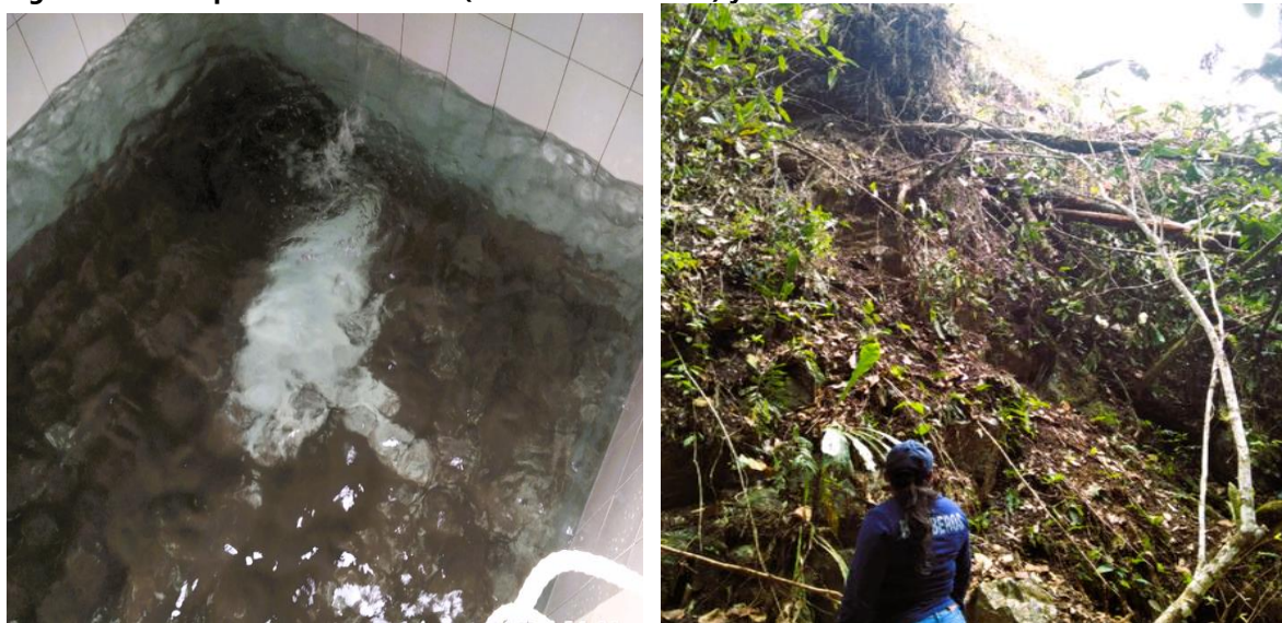
Figura 2.29. Tanques de distribución (sedimento en lecho) y deslizamiento en sector bocatoma
