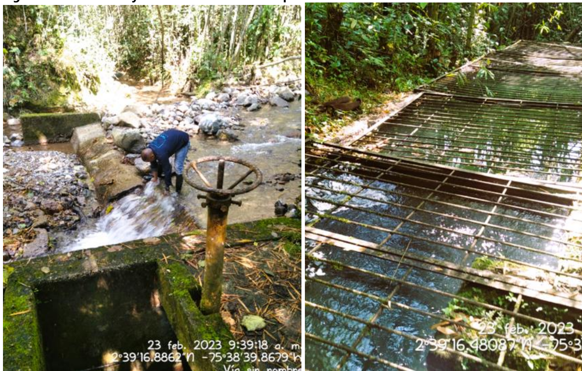
Figura 2.37. Bocatoma y desarenador acueducto íquira
