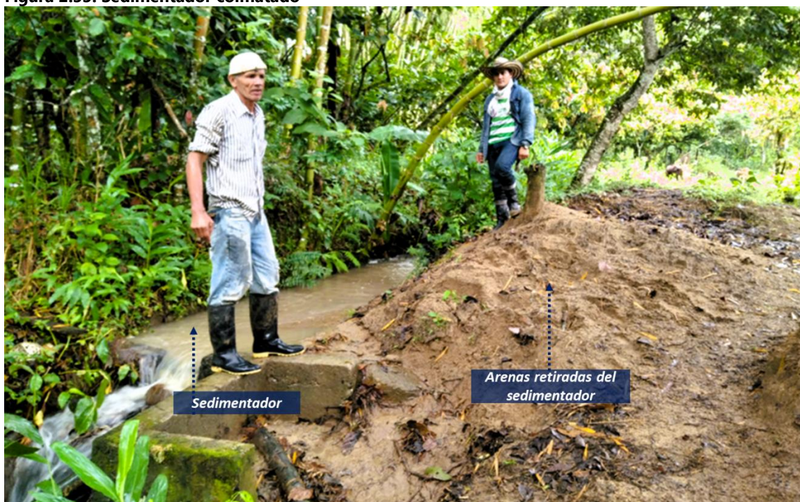
Figura 2.33. Sedimentador colmatado
